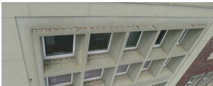
Zdjęcie nr 6: Zabezpieczenie Bird Free na budynku Karstadt w Hamburgu
