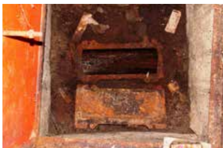
Ilustracja 2: Masowy wylęg spowodowany niezamkniętym otworem rewizyjnym.
